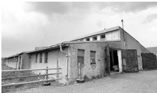
• Maštal' pred rekonštrukciou...
