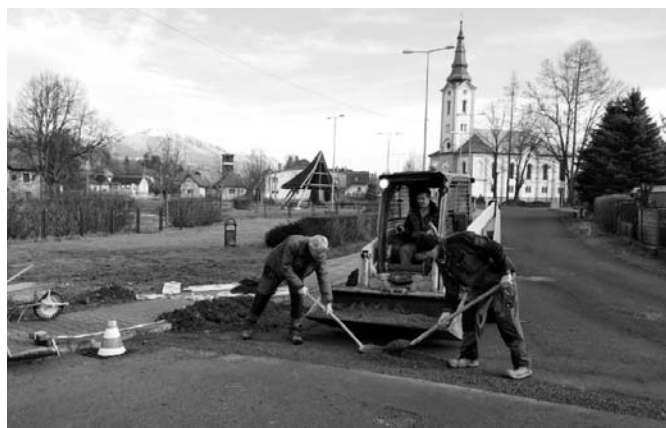
• Dokončovanie dažďovej kanalizácie.
