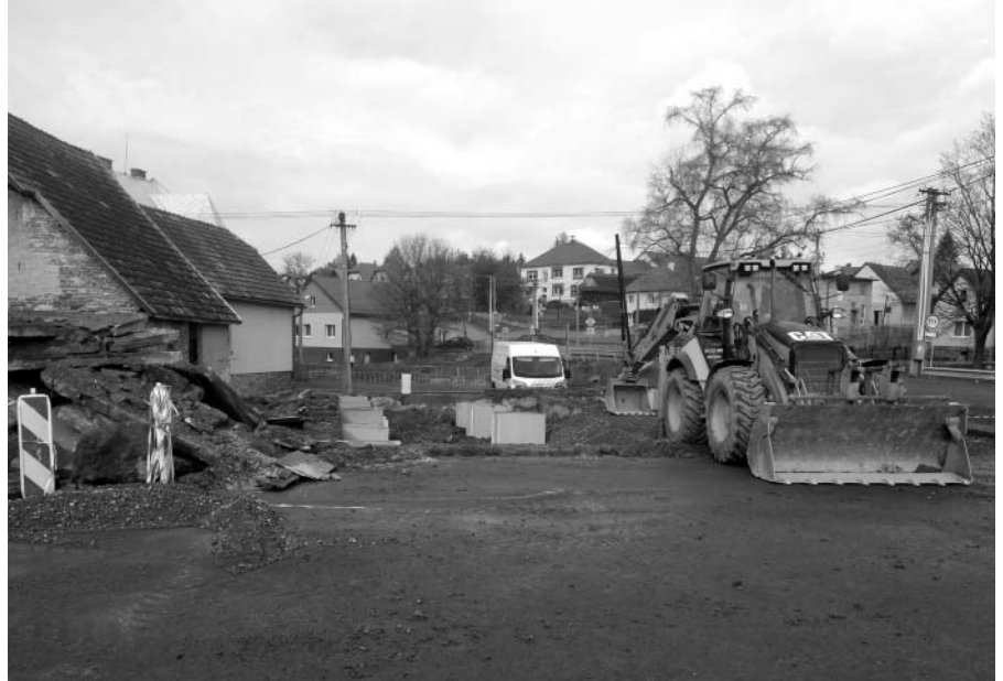
• Stavebným prácam na trhovisku predchádzali statické posudky.
